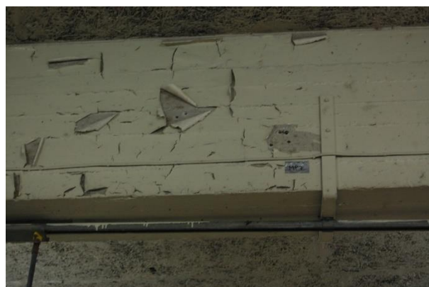
Figur 6. Ubehandlet betongbjelke i tak.
